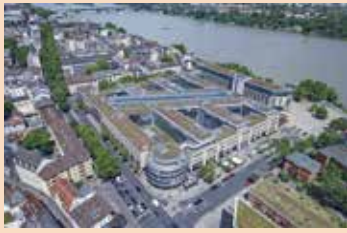
Anlageobjekt Mainz Malakoff Passage
